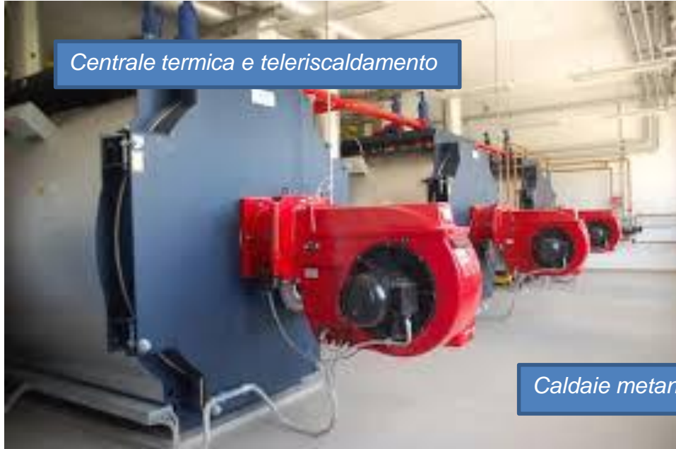
Caldaie Teleriscaldamento @Casaccia 3 x 7MW
